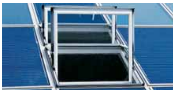
Geschwenkte Fenster in Putzstellung
