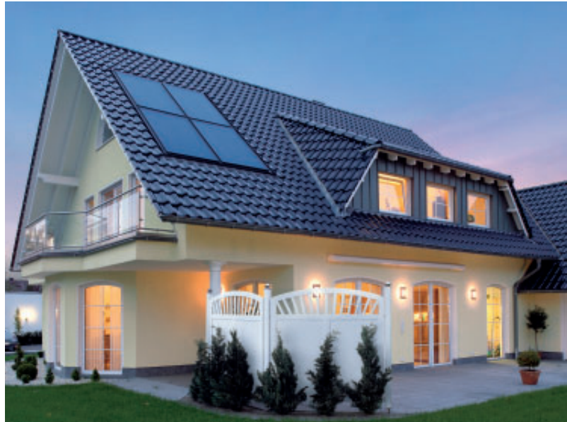
Solarthermieanlage zur Heizungsunterstützung
