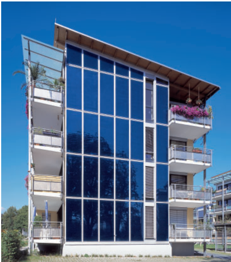
Mehrfamilienhaus mit Fassadenmontage
